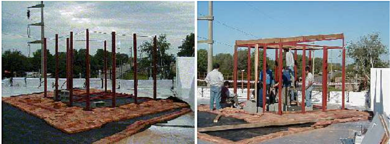
Figura 5: Momentos en las etapas de montaje de la estructura del módulo de ensayos de sistemas constructivos. Puede verse que se realizó un tratamiento del piso para reducir el albedo ya que se encuentra ubicado en la azotea de la escuela donde la membrana aluminizada perturbaría las condiciones de medición.
