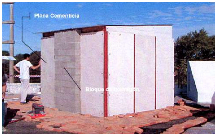
Figura 7: Prototipo MESCoS finalizado donde se observan los dos sistemas constructivos en medición.
